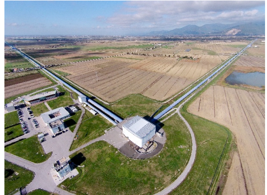
Veduta aerea del rivelatore di onde gravitazionali Virgo, situato a Cascina, vicino Pisa. Virgo è un interferometro di Michelson gigante con bracci lunghi 3km. (Immagine: Nicola Baldocchi / Collaborazione Virgo)
