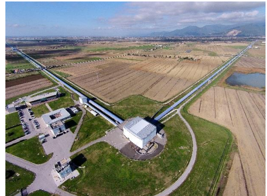
Luftansicht des Virgo-Detektors, gelegen in Cascina, nahe Pisa (Italien). Virgo ist ein gigantisches Michelson-Laserinterferometer mit 3 km langen Armen. (Foto: Nicola Baldocchi / Virgo Collaboration)
